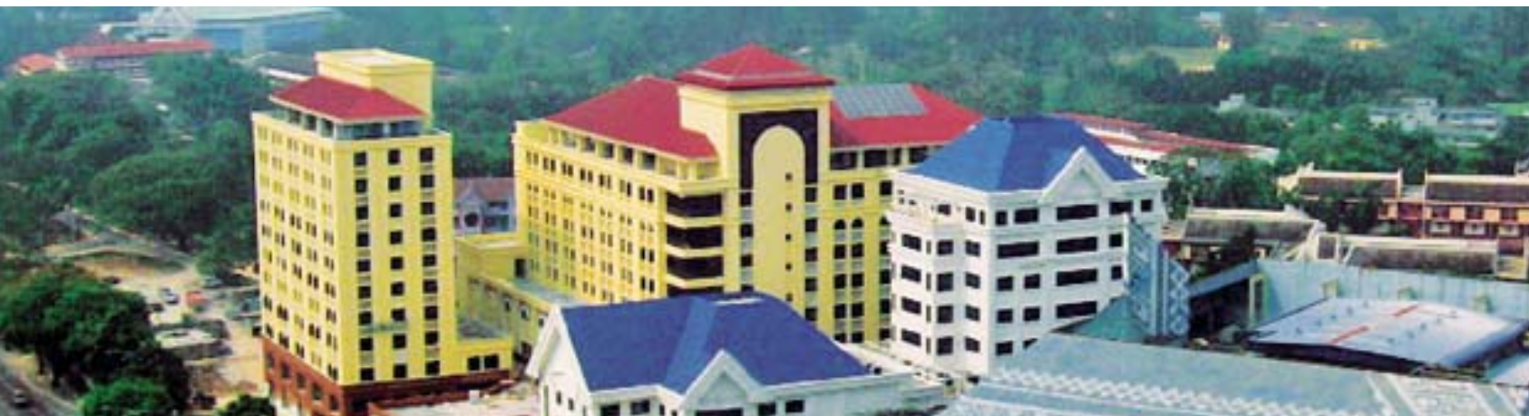
Pembinaan Hospital PUSRAWI di Jalan Tun Razak, Kuala Lumpur.
